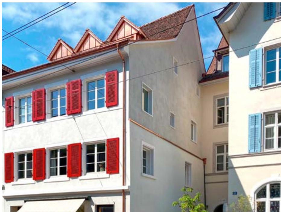
Die sanierte Nordfassade mit zusätzlichen Fenstern erstrahlt in neuem Glanz
