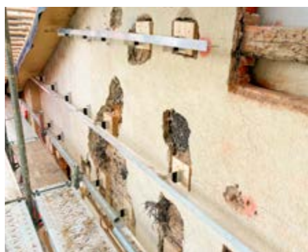
Die vorgehängte Konsolenkonstruktion des Fassadensystems POLYROC
