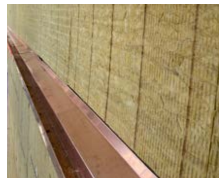
Zweite Dämmschicht des zurückversetzten Fassadenteils – Flumroc-Dämmplatte LENIO
