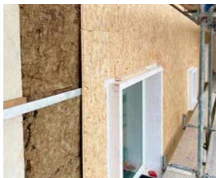
Erste Dämmschicht des zurückversetzten Fassadenteils – Flumroc-Dämmplatte 1 mit Traggrundplatte
